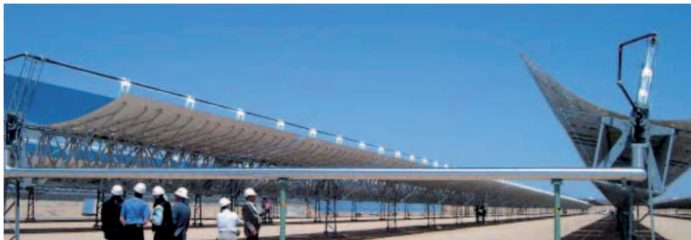
Obrázek č. 5: Koncentrační sluneční tepelné elektrárny (CSP)
